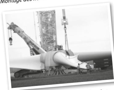
Assemblage des pales sur le rotor
